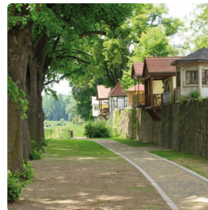
Historische Stadtmauer am Muldenufer. Wichtiges Anliegen eines integrierten Hochwasserschutzes ist die möglichst ungestörte Erhaltung der wertvollen Baudenkmale und des charakteristischen Stadtbilds.
