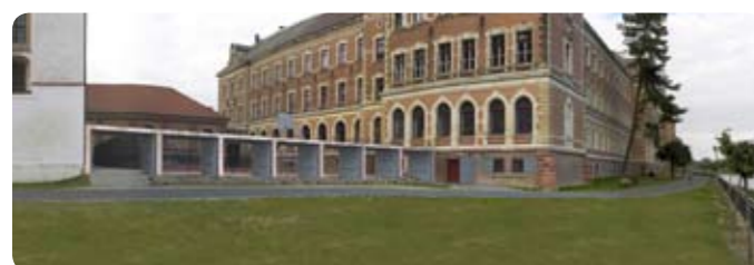
Hochwasserschutzwand mit großen Öffnungen auf dem Schulgelände
