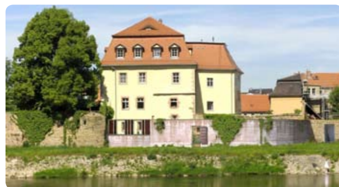
Neue Mauer um das Muldegärtchen
